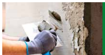
Sanace / renovace renovace ve stylu
