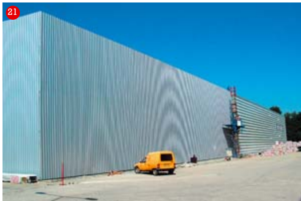
Kompletace kazetového systému ROCKPROFIL – celkový pohled
