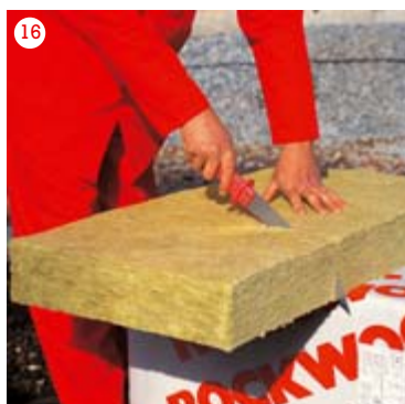
4. Řezání izolace - izolaci lze řezat speciálním nožem, případně nožem se zuby
