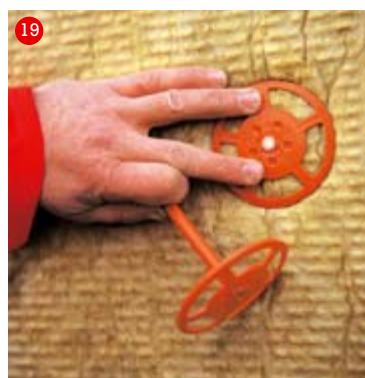
7. Kotvení izolace pomocí držáků izolace DH
