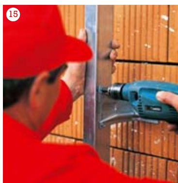
3. Montáž nosných profilů pro obklad
