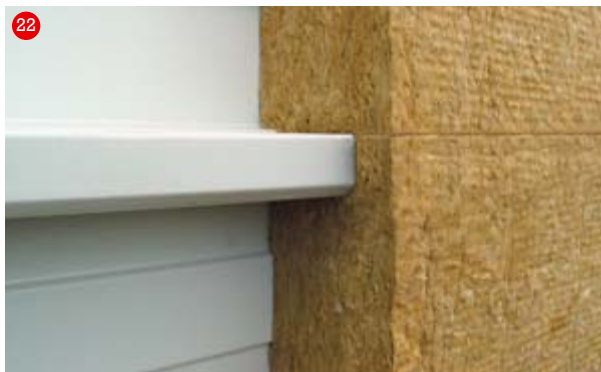
Izolační deska Airrock ND přesahuje kazety o 40 mm
