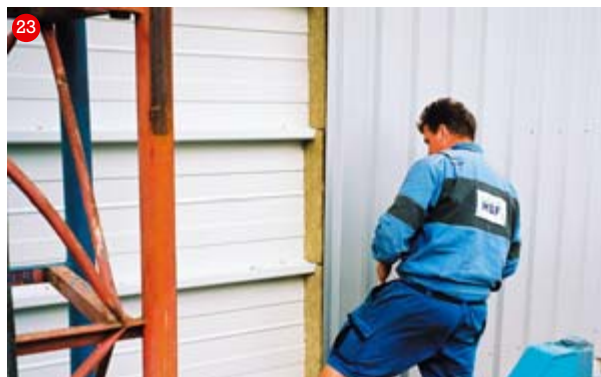
Vyrovňování obkladového trapézového plechu na soklu stavby
