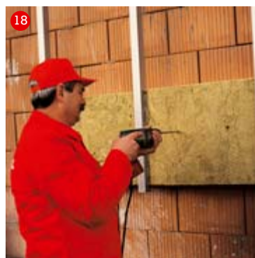
6. Vrtání otvoru pro taliřové hmoždinky, sloužící k uchycení tepelné izolace
