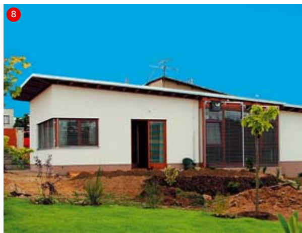
Fasáda zateplená kontaktním systémem
