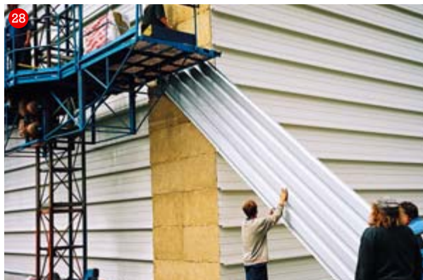
Přesun obkladového plechu na fasádu
