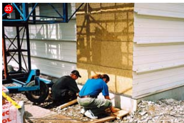
Po vložení izolačních desek Airrock ND (pro ROCKPROFIL) se připravuje montáž obkladového plechu
