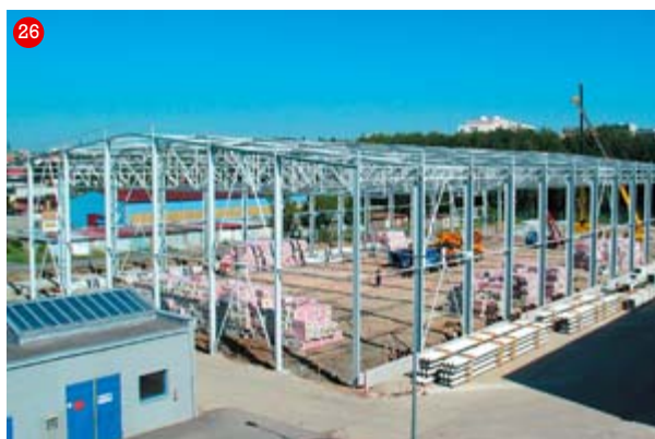
Montáž skeletu stavby
