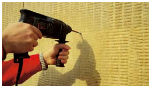
Vrtání otvoru pro hmoždinku (obr. 28)
