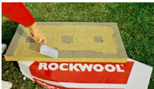
Lehké přestěrkování desky v místě aplikace lepidla (obr. 14)
