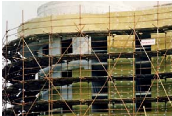
Aplikace Fasrock L na oblou stěnu (obr. 41)
