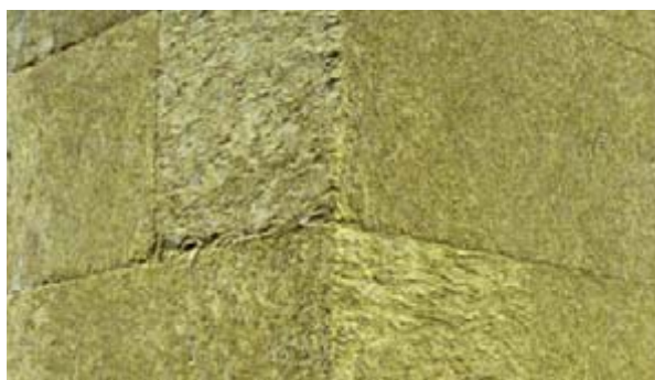
Pokládka desek v nárožích musí být řešena na vazbu (obr. 20)
