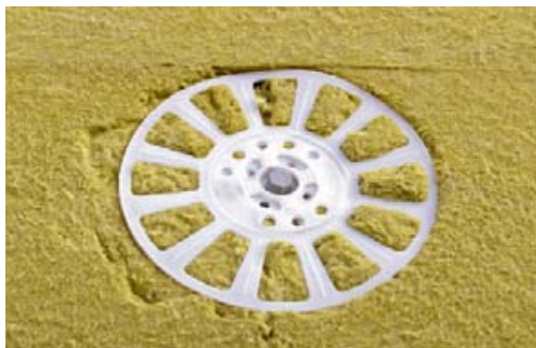
Ukotvení lamel Fasrock L talířovou hmoždinkou (obr. 33)
