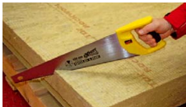
Řezání fasádních desek speciální pilkou (obr. 26)
