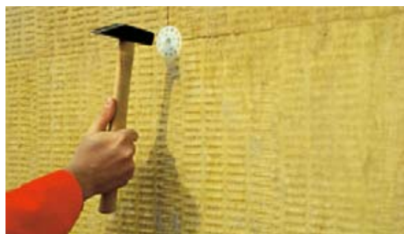
Upevnění talířové hmoždinky (obr. 29)
