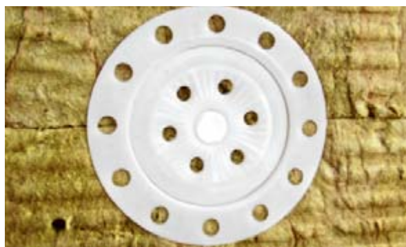
Správně osazená mechanická kotva s termoizolační zátkou. Talířek lícuje s povrchem desky Frontrock MAX E (obr. 37)
