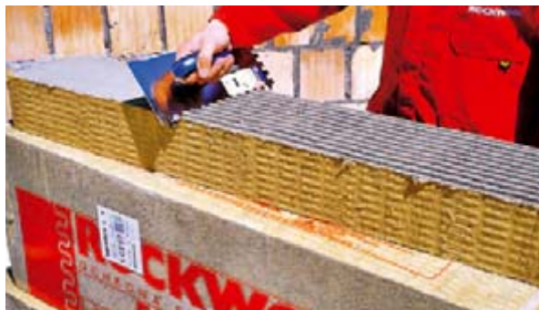
Nanášení lepicí hmoty u desek Fasrock L (obr. 13)
