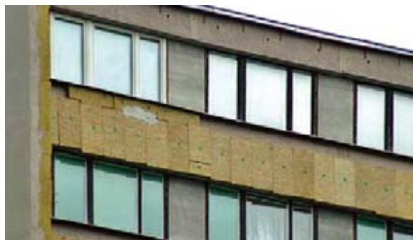
Chybné řešení pokládky desek (obr. 19)
