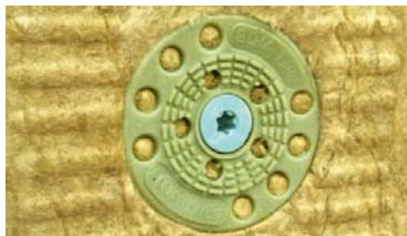
Ukázka správně zapuštěné hmoždinky (obr. 30)
