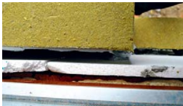
Nevhodná aplikace desek – zakázané tzv. podlepování (obr. 17)
