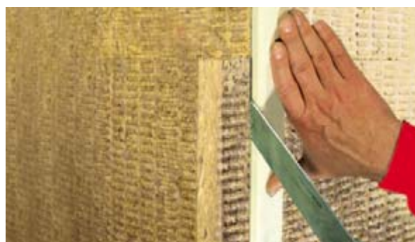
Odstranění přebytečné izolace v rohu (obr. 25)
