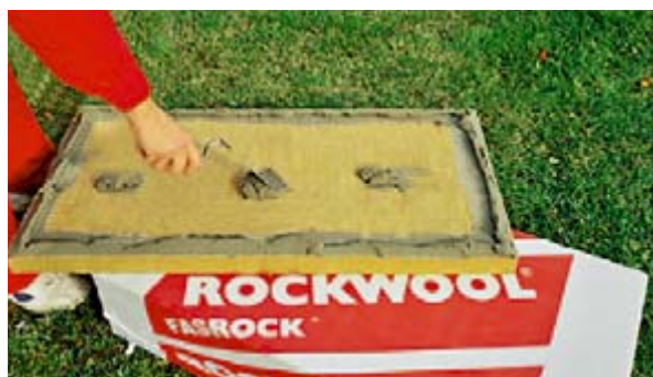
Nanášení terčů a válečků (obr. 15)
