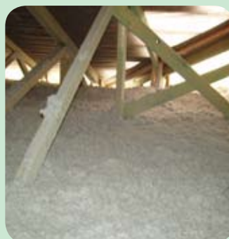
Foukání TEMPELANu na rovnou plochu půdy rodinného domu
