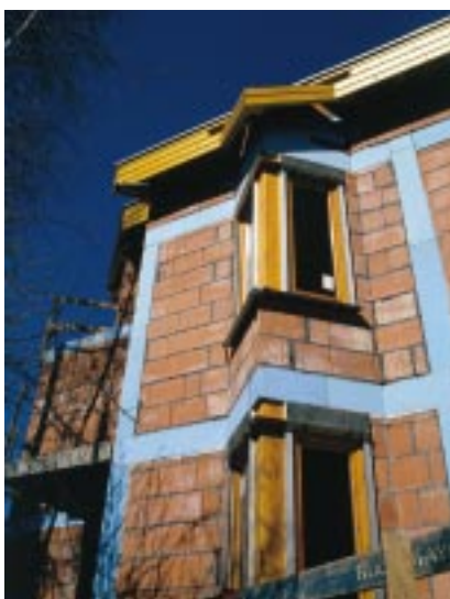
Stávající tepelně neizolovaný okenní překlád
