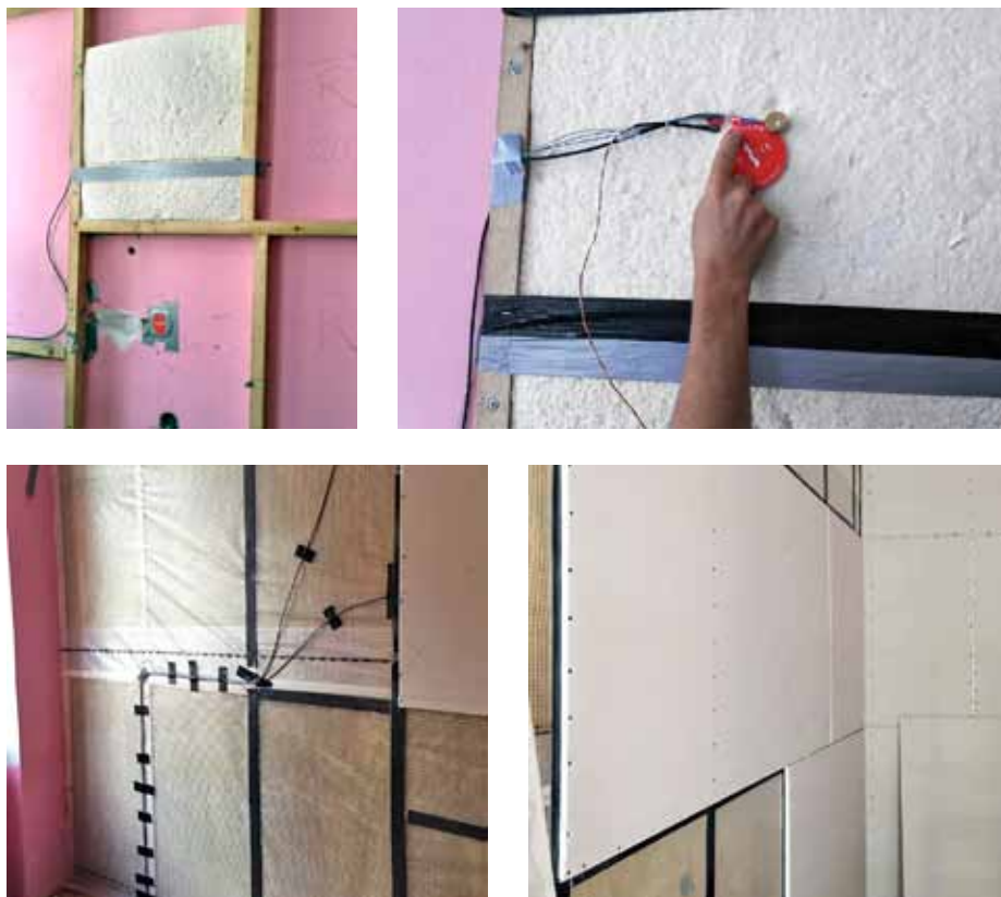
Obr. 9–12: Instalace panelů BRIMEE (červenec 2016)
