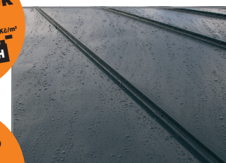
Stavební šíře 535 mm
