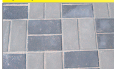
plnění spár zámkových dlažeb
