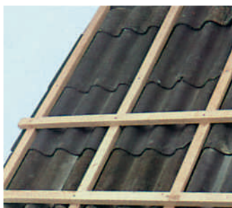
Příklad překrytí staré střechy.
