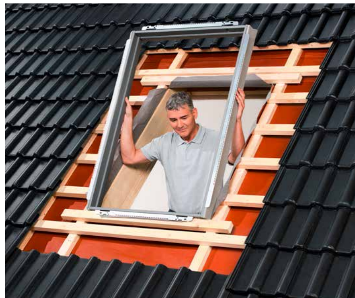
Zateplovací sada BDX usnadňuje přípravu okna k montáži a zajišťuje energeticky úspornější řešení.
