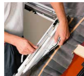
Lepný spoj fólie BDX a hydroizolační fólie
