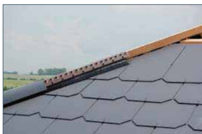
Velikost výstupního otvoru při větrání hřebenem je 100 \text{ cm}^2/\text{bm} . Větrací mezera 1 \text{ cm}/\text{bm} .
