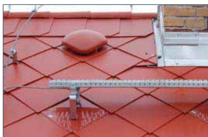
Velikost výstupního otvoru plastové větrací hlavice je 200 \text{ cm}^2/1 \text{ ks} .
