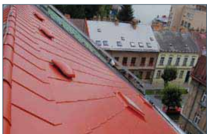
Větrání střešního pláště je realizováno plastovými hlaviciemi.
