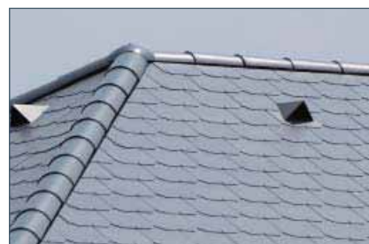
Velikost výstupního otvoru větrací hlavice Oriko je 100 \text{ cm}^2/1 \text{ ks} .
