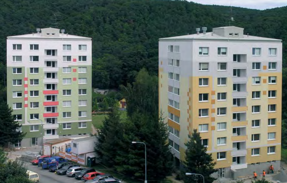
Realizace šikmých střech LindabRoof na bodových panelových domech
