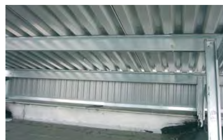
Pohled do půdního prostoru před položením tepelné izolace
