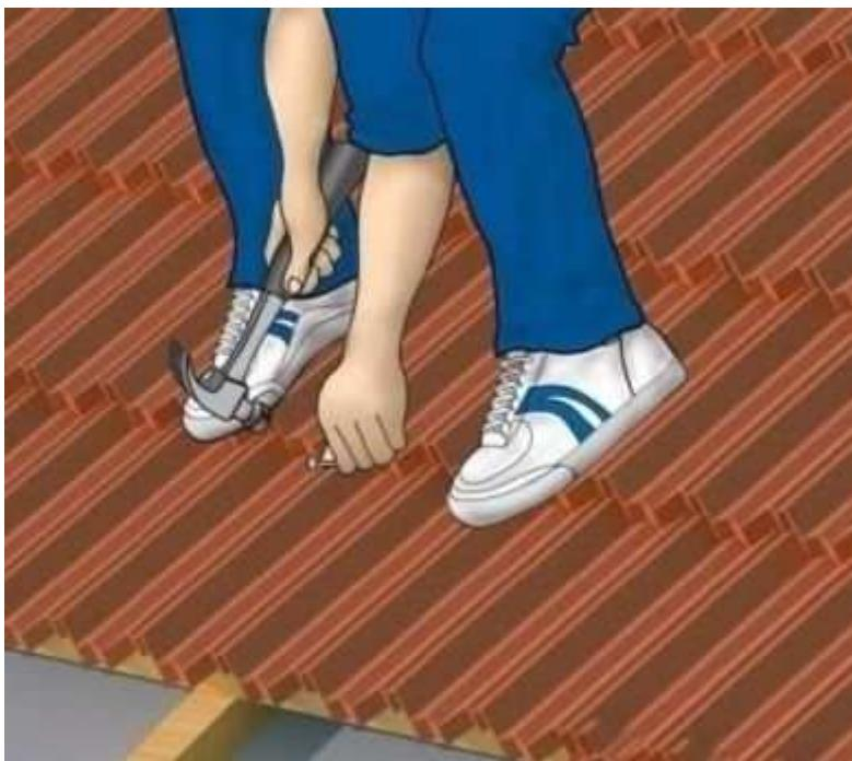
Obrázek demonstруjící ruční přibíjení šablon
