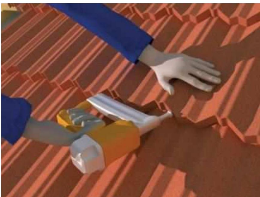
Obrázek demonstруjící přibíjení šablon hřebíkovačkou
