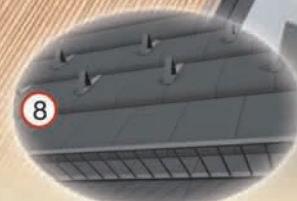
Opatření proti sesuvu sněhu
