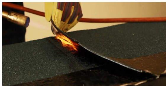
Obr. D2 Natavení příčného přesahu
