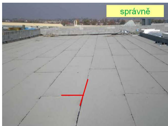
Obr. D3 Spoje tvaru T - správně
