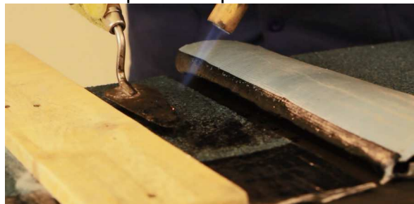
Obr. D1 Nahřátí povrchu a zatlačení drcené břídlíce do asfaltové hmoty
