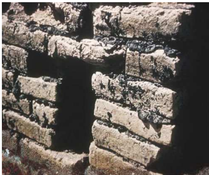
Obr. 01 Historické zdivo „izolované“ přírodním asfaltem
