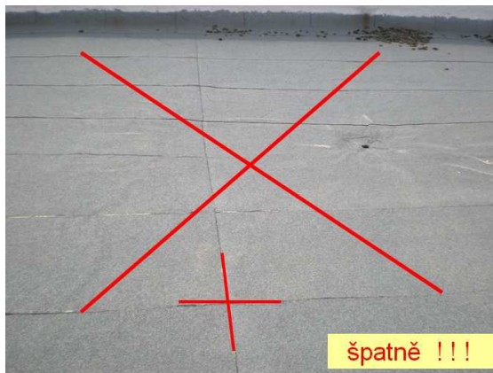
Obr. D4 Spoje tvaru X - špatně
