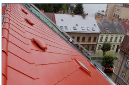
Větrání střešního pláště je realizováno plastovými hlaviciemi.
