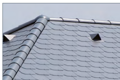
Velikost výstupního otvoru větrací hlavice je 100 cm 2 /1ks.
