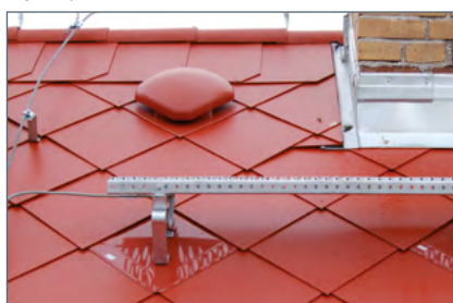
Velikost výstupního otvoru plastové větrací hlavice je 200 cm 2 /1ks.
