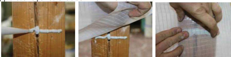
NAPOJENÍ PAROZÁBRANY A PAROBRZDY NA NEDROLIVÉ ZDIVO
