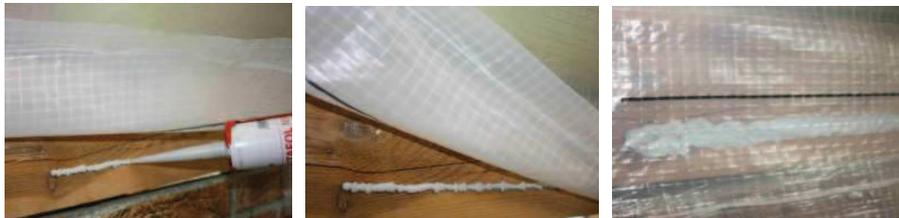
NAPOJENÍ PAROZÁBRANY A PAROBRZDY NA NEHOBLOVANÉ DŘEVO S PUKLINOU
