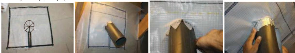
NAPOJENÍ PAROZÁBRANY NA RÁM STŘEŠNÍHO OKNA (popř. na rám průlezu do půdy)
