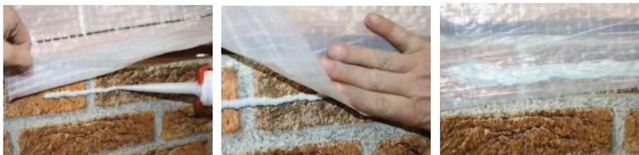
NAPOJENÍ PAROZÁBRANY A PAROBRZDY NA DROLIVÉ ZDIVO
