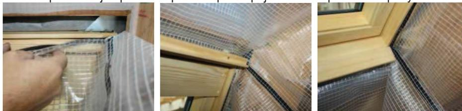
PŘÍKLADY MONTÁŽE PAROZÁBRANY K NEDROLIVÉMU ZDIVU**a) Aplikace parozábrany z interiérové strany SDK profilů s páskou JUTAFOL PROF pod roštem pro podhled**
