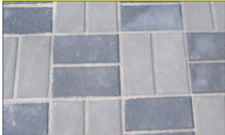
plnění spár zámkových dlažeb
