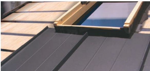
Osazení spodních šablon upravených do potřebného tvaru.
