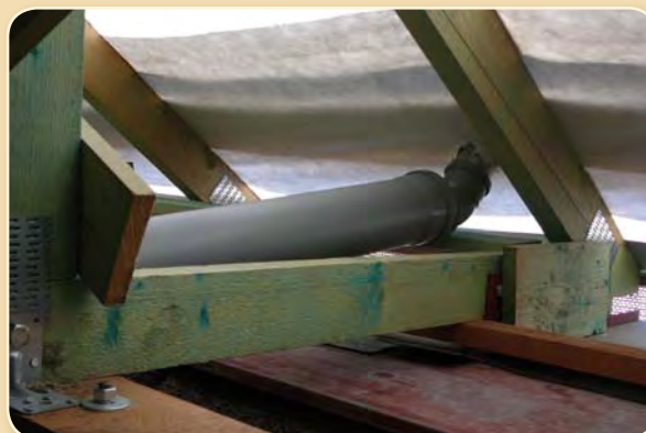
Napojení žlabového kotlíku
